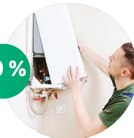
Remplacement de chaudière
